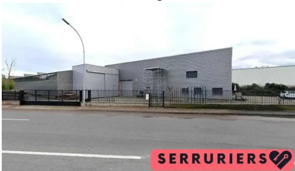
Serrurerie metallerie du val d ouest saint priest
