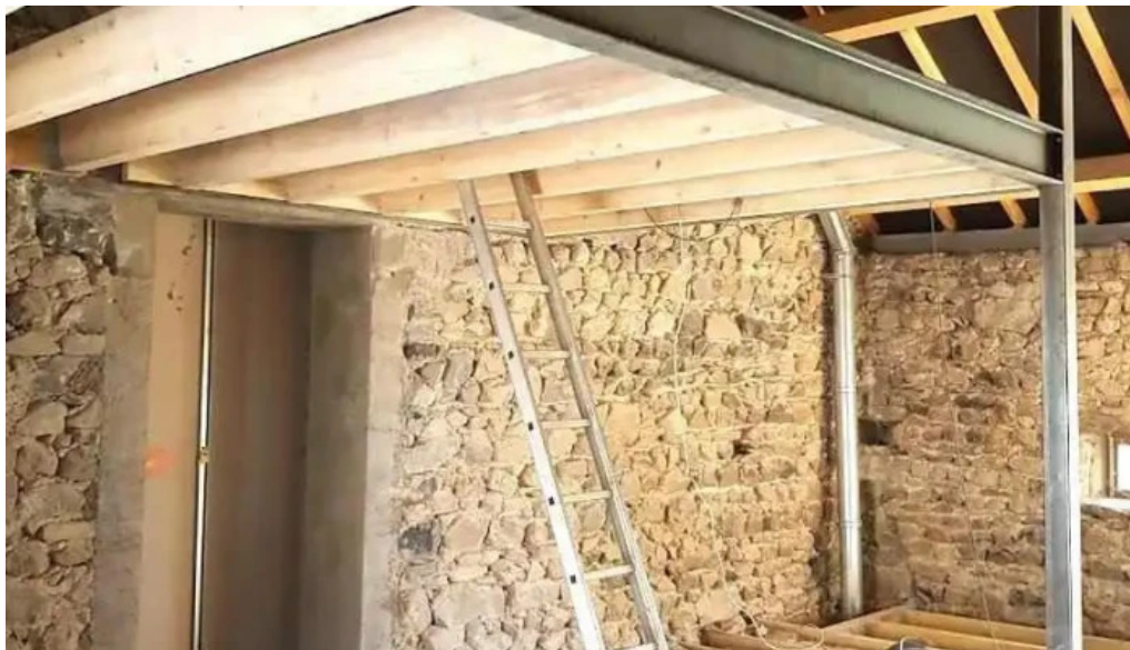
Mettallier entreprise gms saint ours
