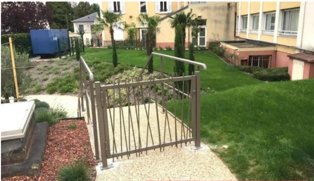
Serrurerie metallerie du roannais le coteau
