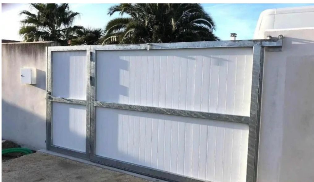
Metal d ile portail verrieres soudeur escalier ile de re la courarde sur mer
