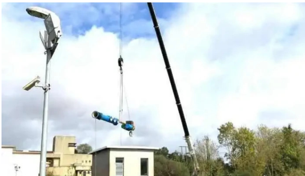
Ms 79 maintenance industrielle chaudronnerie tuyauterie photos du proprietaire
