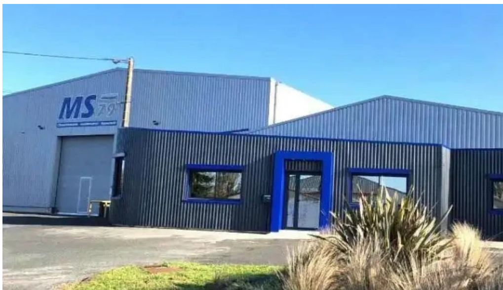
Ms 79 maintenance industrielle chaudronnerie tuyauterie tout
