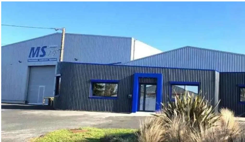
Ms 79 maintenance industrielle chaudronnerie tuyauterie brioux sur boutonne
