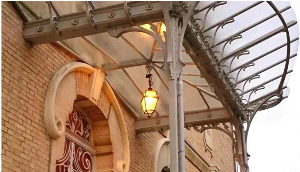
Multi pose serrurerie tout
